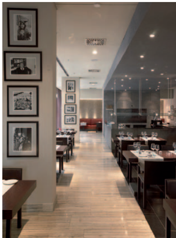
Bild 6: Radialer Lamellenauslass, deckeneben eingebaut
