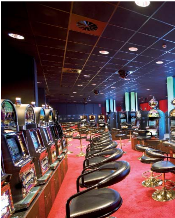
Radialauslass mit quadratischer Sichtfläche in einem Spielkasino
