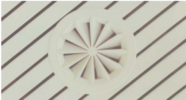
Radialauslass in einer Paneeldecke
