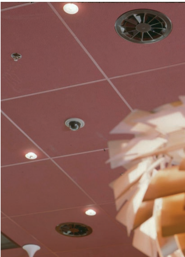
Bild 7: Verstellbarer Radialauslass in der Decke eines Restaurants, Ausschnitt
