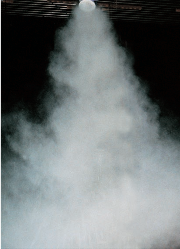
Bild 6: Vertikales Ausblasen im Heizfall aus großer Höhe
