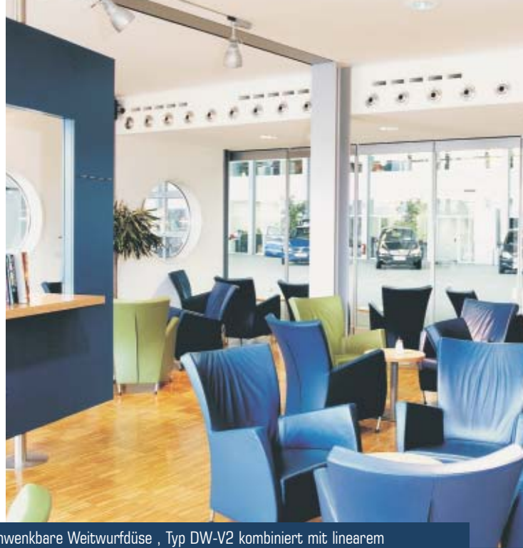
Drallauslaß mit eckigem Auslauf, Typ D-NE in der Ausstellungshalle Art Cult Center "Tabakmuseum", Wien / A
