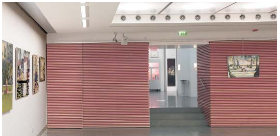
Drallauslaß mit eckigem Auslauf, Typ D-NE in der Ausstellungshalle Art Cult Center "Tabakmuseum", Wien / A
