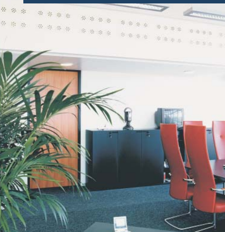
Fächerauslaß, Typ FA-VT, 2-reihig, im Bürobereich Flughafen Stuttgart
