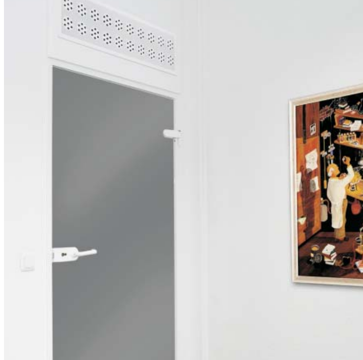
Breitfächerauslaß, Typ BF in einem Büroraum
