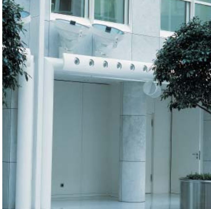
Schwenkbare Weitwurfdüse, Typ DW-V2 im Eingangsbereich der Dresdner Bank AG, Frankfurt
