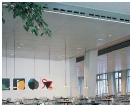
Linearer Wirbelauslaß, Typ WL in der Kantine "Verlagshaus Gruner & Jahr AG & Co.", Hamburg
