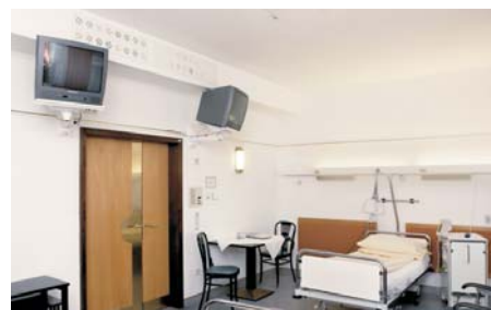
Kombinierter Fächerauslaß, Typ FA-VK in einem Bettenraum der Wiener Privatklinik, Wien / A
