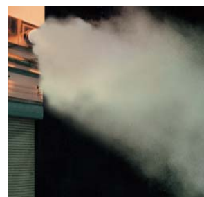
Luftstrahlausbildung SW Strahlrichtung schräg nach unten (Heizfall)
