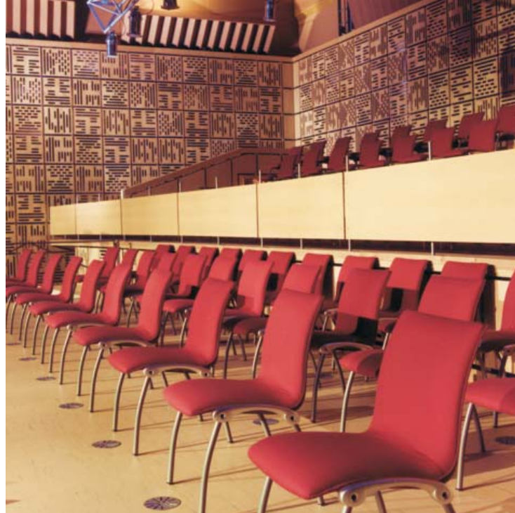
Verstellbarer Bodenauslaß, Typ BA-V-DN 150 in den VARA-Studios, Hilversum / NL
