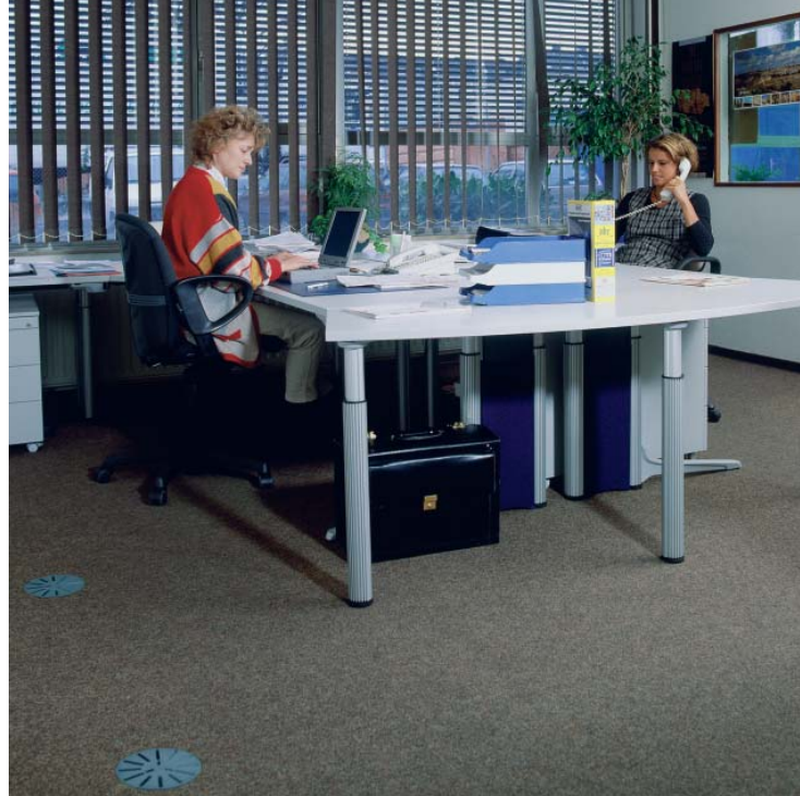
DN 150 in einem Büroraum
