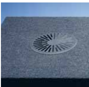
2 Turbulente Mischlüftung Bodendrallauslaß DB-E-DN 200
