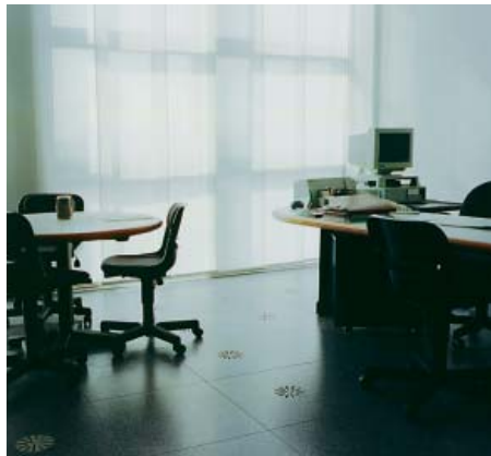
DN 150 im Großraumbüro (Ausschnitt) Siemens Mailand / Italien
