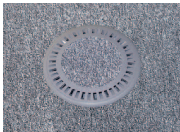
Bild 2: Bodenquellauslass in einem Doppelboden
