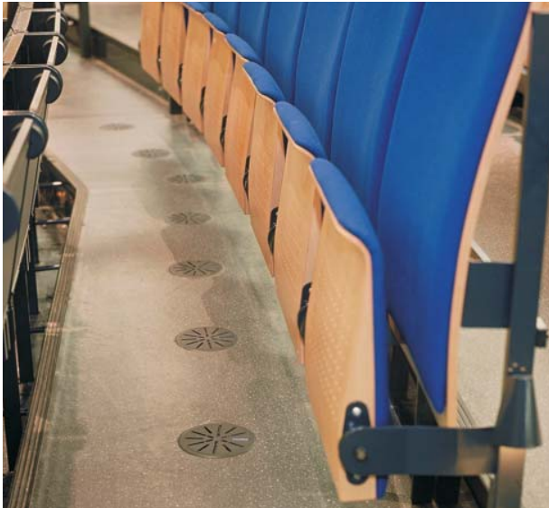
Bodenquellauslaß, Typ Q-B-DN 200 in einer Bodenplatte mit Spanneinsatz
