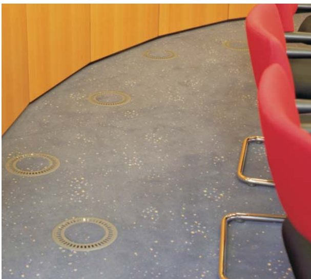
Bodenquellauslaß, Typ Q-B-DN 215 in einem Konferenzraum, Toto-Lotto Rheinland-Pfalz, Koblenz
