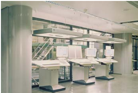
Halbrunder Quellauslaß, Typ Q-ZH in Sonderausführung am Leitstand der Druckerei Axel Springer Verlag, Essen
