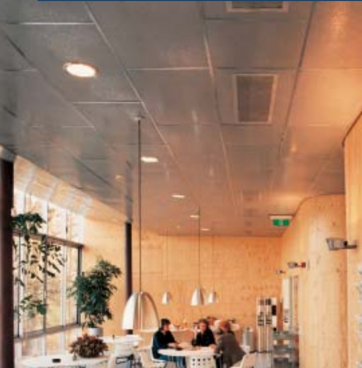
Deckenquellauslaß, Typ Q-DN in der Kantine "Mediapark RVU", Hilversum / NL
