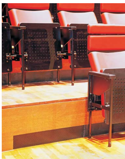
Stufenquellauslaß, Typ Q-SL im Vortragssaal der "Botschaft der Nordischen Länder", Berlin
