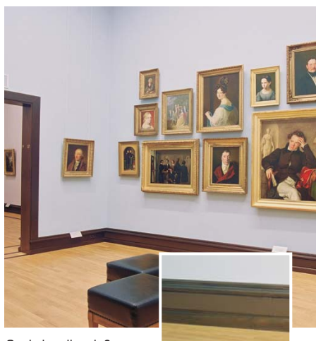
Sockelquellauslaß, Typ Q-S in der Kunsthalle Bremen
