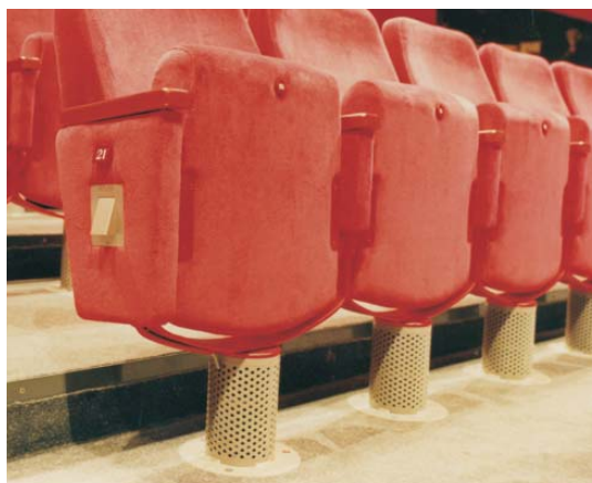
Stuhlquellauslaß, Typ Q-St in einem Zuschauerraum der Musical Production GmbH, Berlin
