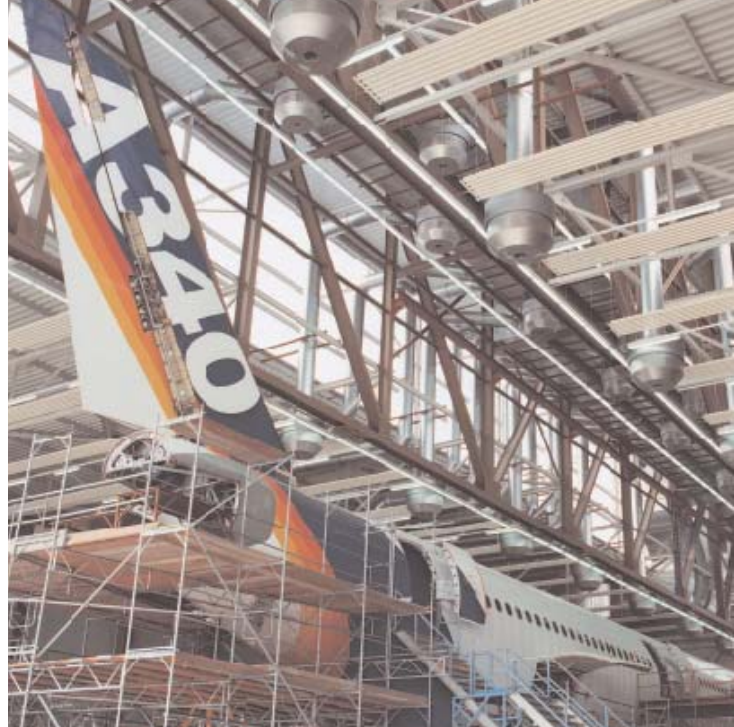
Kegelförmiger Verdrängungsauslaß, Typ VA-K in der Lackier- und Wartungshalle "Aircraft Services GmbH", Lemwerder
