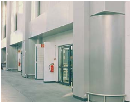
Viertelrunder- und Rechteckiger Verdrängungsauslaß Axel Springer Verlag, Essen-Kettwig
