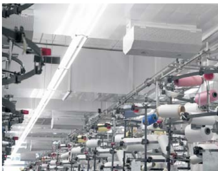
Trapezförmiger Verdrängungsauslaß, Typ VA-T Wolford AG, Bregenz / A
