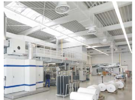
Radialer Verdrängungsauslaß, Typ VA-PV Scheyer Verpackungstechnik GmbH, Klaus / A
