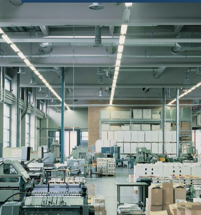
Radialer Verdrängungsauslaß, Typ VA-PV in der "Frankfurter Societäts-Druckerei", Mörfelden
