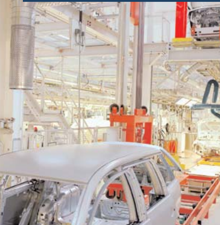
Runder Verdrängungsauslaß, Typ VA-ZD in der Produktionshalle "VW-Emden", Emden
