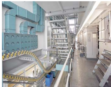
Rechteckiger Verdrängungsauslaß, Typ VA-RN Druckerei Vorarlberger Medienhaus, Schwarzach / A
