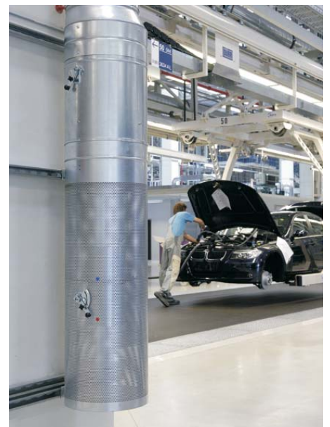
Runder Verdrängungsauslaß, Typ VA-ZD BMW AG, Leipzig (Fotograf: Martin Klindtworth)
