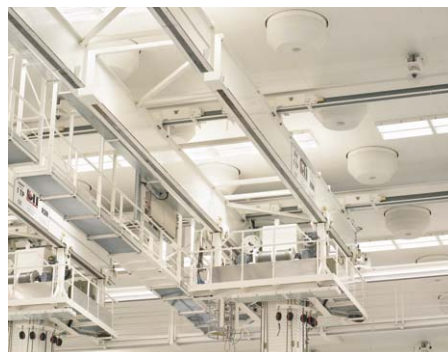
Kegelförmiger Verdrängungsauslaß, Typ VA-K Flugzeug-Lackierhalle Deutsche Airbus, Hamburg
