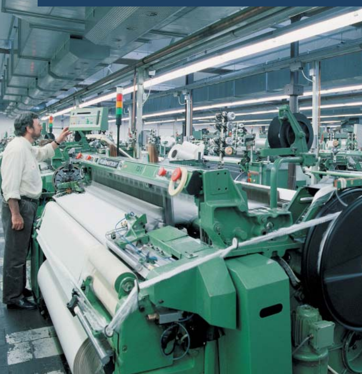
Trapezförmiger Verdrängungsauslaß, Typ VA-T in der Weberei der Firma "Verseidag", Viersen
