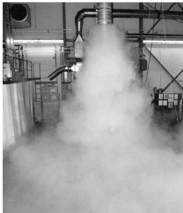
Bild 5: Ausbreitung der Luftstrahlen, durch Rauchprobe sichtbar gemacht, oben: Kühlfall; unten: Heizfall
