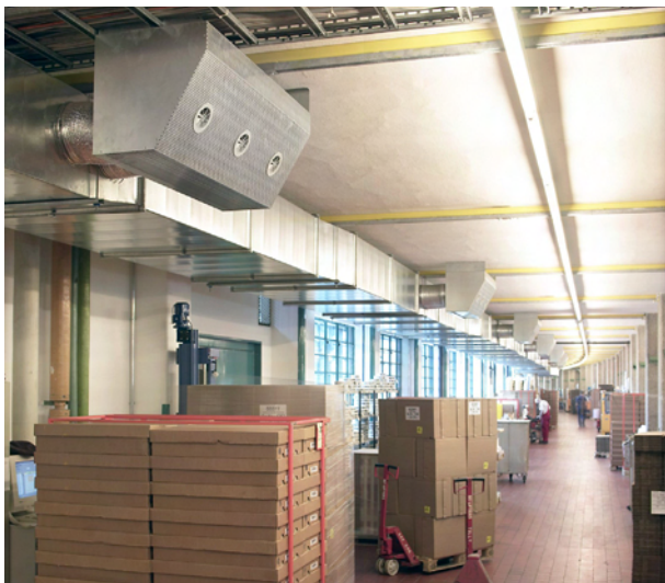
Bild 9: Halbtrapezförmiger Verdrängungsauslass, Baugröße 500 in einem Produktionsbetrieb
