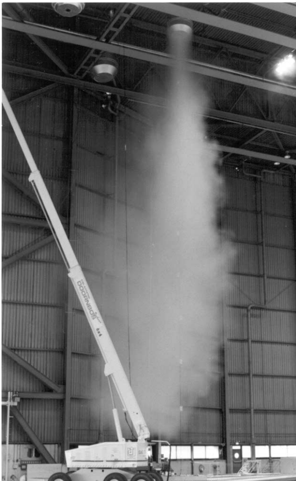
Bild 5: Eindringtiefe der Zuluftstrahlen durch Rauch- probe sichtbar gemacht
