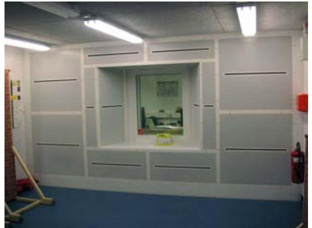
Neue Ausführung Fabrikat KRANTZ KOMPONENTEN mit Erreichung der optimalen Raumluft-geschwindigkeit und Strömungsrichtung
