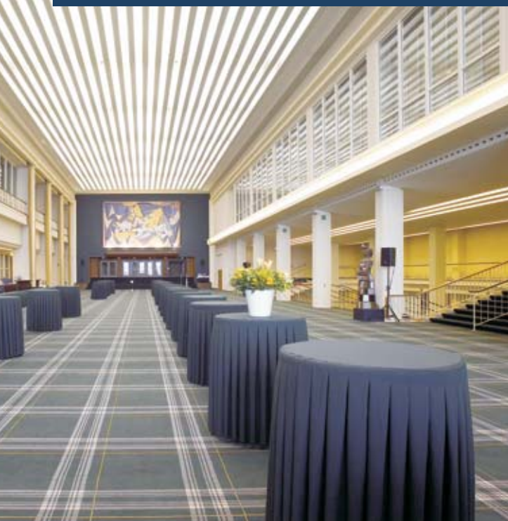
Lineare Wirbelauslässe, Typ WL-2 im Eingangsbereich des Kursaals im Casino Oostende / B
