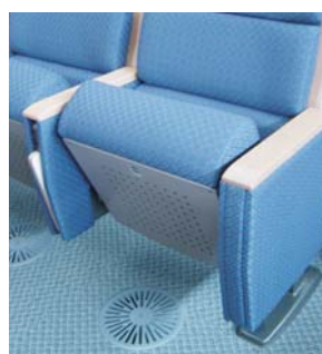
Bodendrallauslaß, Typ DB-E im Media Center of Osaka University of Commerce
