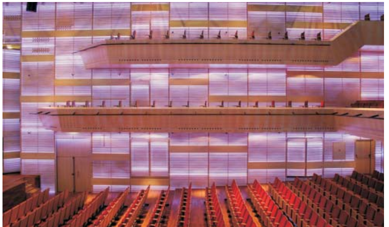
Weitwurfdüsen und Stuhlquellauslässe im Muziekgebouw aan 't IJ Amsterdam / NL
