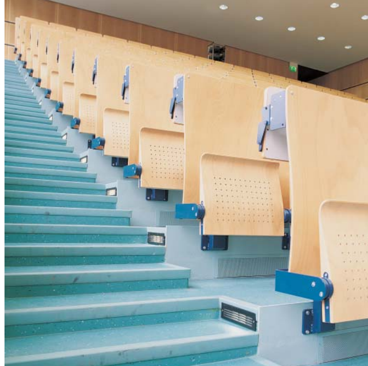
Stufenquellauslaß, Typ Q-SL in einem Vorlesungssaal der Fachhochschule Lausitz, Cottbus
