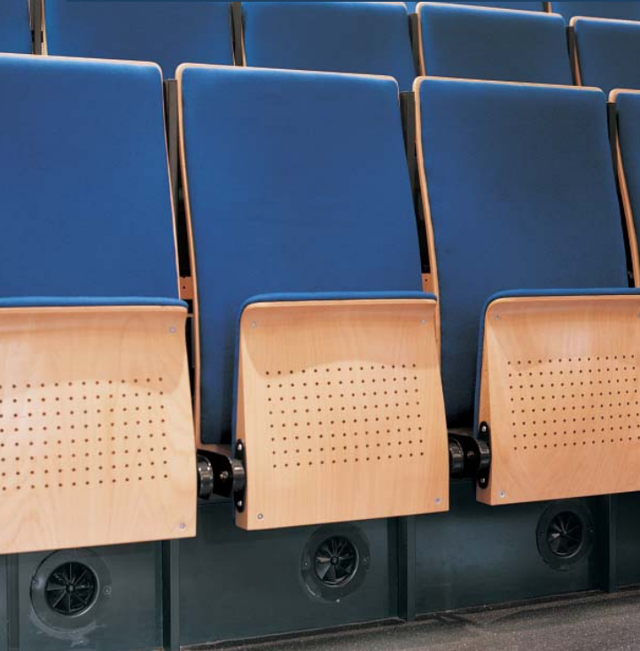
Stufendrallauslaß, Typ DS-DD in einem Vorlesungssaal der Universität Amsterdam / NL
