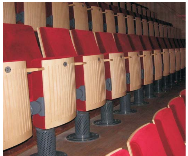
Stuhlquellauslaß, Typ Q-St im Muziekgebouw aan 't IJ Amsterdam / NL
