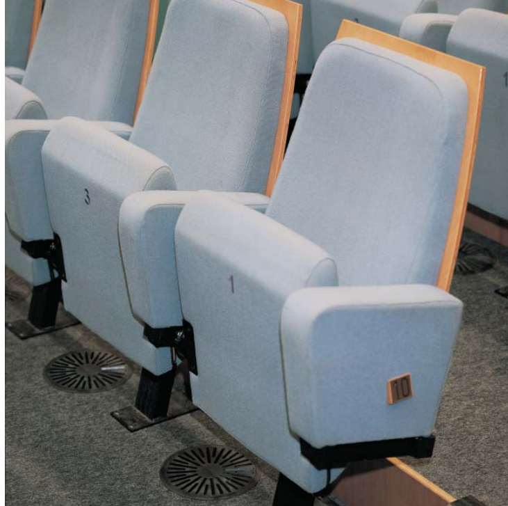
Bodendrallauslaß, Typ DB-E im Theater "Markant", Udem / NL
