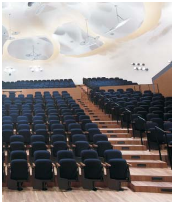
Stufenquellauslaß, Typ Q-St Beiersdorf, Hamburg
