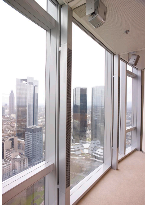
LUVAS-Stabsystem als vertikaler Pfosten
