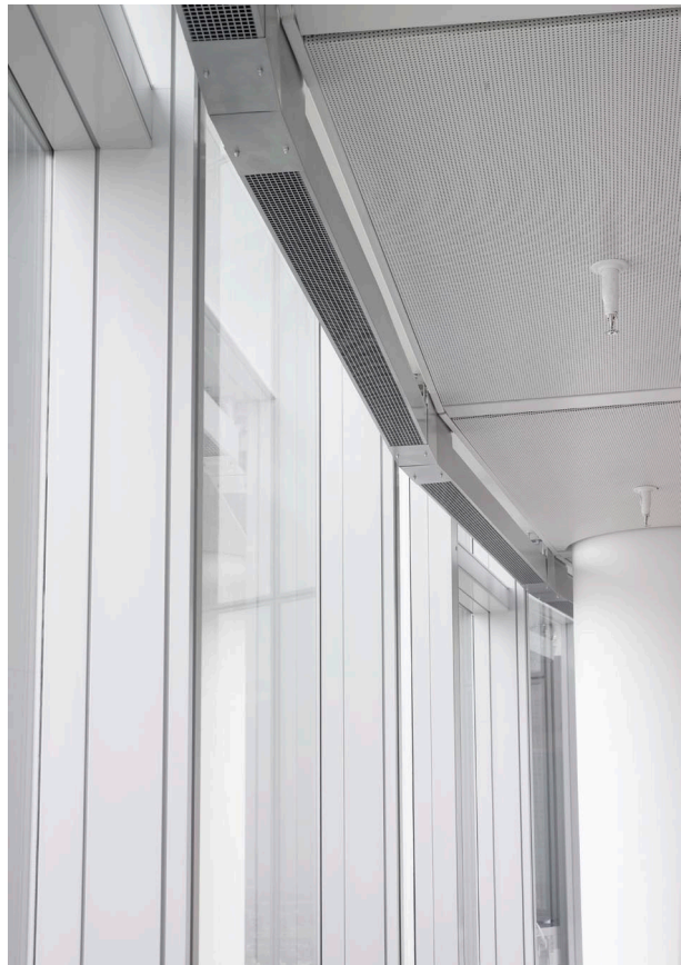
LUVAS-Stabsystem als horizontaler Riegel im Deckenbereich
