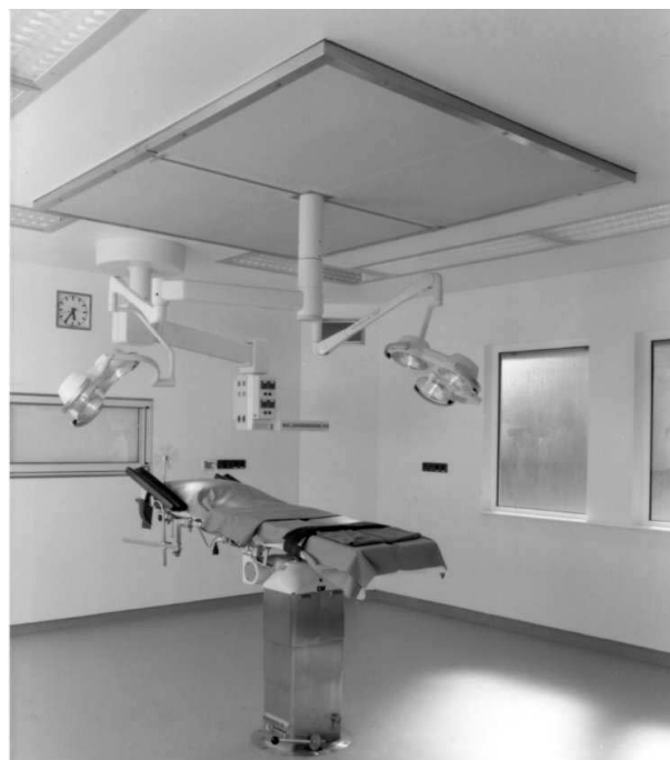
Bild 8: Luftdurchlaßgehäuse deckenbündig (nicht sichtbar) eingebaut; Ausblaselement unterhalb der Zwischendecke, geteilt mit Leuchtdurchführung
