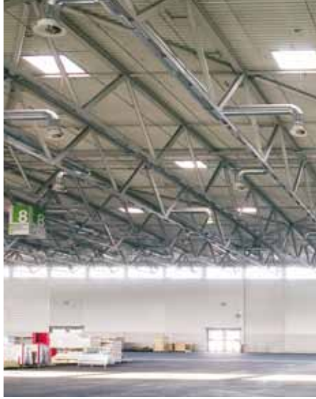
Ayarlanabilir dairesel çıkış, Tip RA-V2 (Poz. 1.4.2., sayfa 8)
