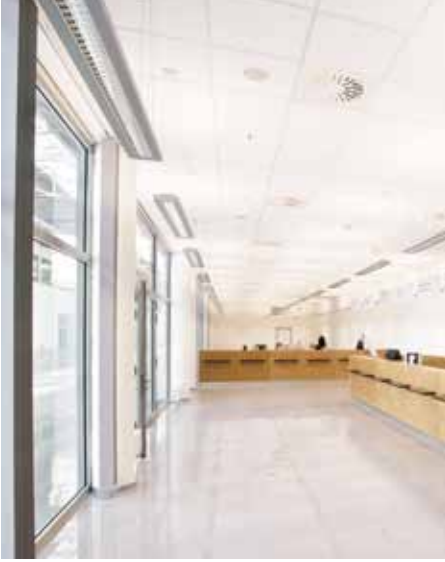
Dairesel slot çıkışı, Tip RL (Poz. 1.2.1., sayfa 7)
