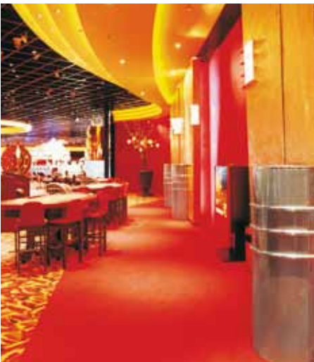
Holland Casino, Utrecht / NL Yarı dairesel deplasmanlı hava dağıtımı, Tip Q-ZH (Poz. 4.2.2., sayfa 16)
