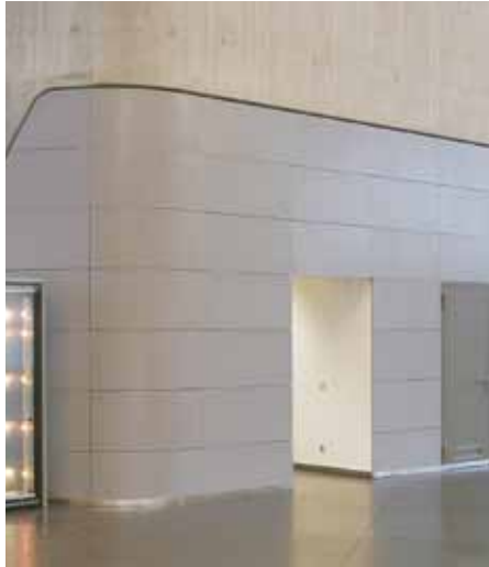
BMW AG, Leipzig / D Dikdörtgen deplasmanlı hava dağıtımı, Tip Q-R (Poz. 4.1., sayfa 16)
