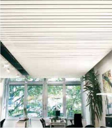
Rahmann ofis binası, Eschborn / D Statik tavan tipi soğutma sistemi, gizli montaj için, Tip SKS-4/3 (Poz. 1.1.1., sayfa 25)
