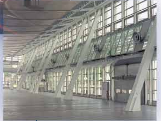
Hanover Fuar alanı, Hol 26 Swirl jet difüzörleri ve deplasmanlı hava dağıtıcılar (cam kanallarda)
