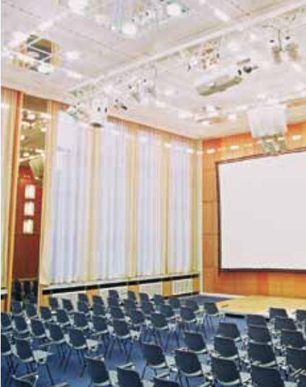
Endüksiyonlu hava dağıtım, Tip IN-N-6 (Poz. 1.8., sayfa 10)
