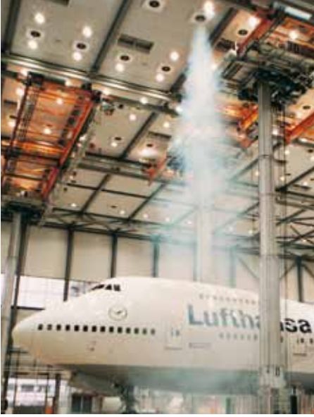
Lufthansa AG, Hamburg / D Değişken debili twist difüzör, Tip D-VG (Poz 1.6.4., sayfa 9)
