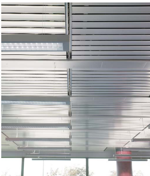
Adjustable induction outlet, type IN-V, at 'Reifenhäuser GmbH & Co. KG Maschinenfabrik', Troisdorf / D
