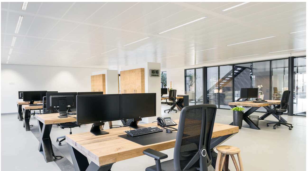
Bild 14: Opticlean in rechteckigen Deckenplatten eines Büroraums
