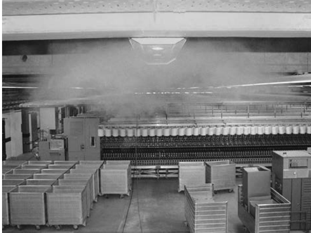
Bild 6: Trapezförmiger Verdrängungsauslass, Strahlausbreitung durch Rauchprobe sichtbar
