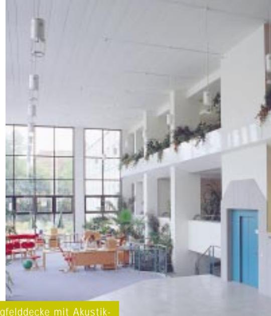
Metall-Langfelddecke mit Akustikbeschichtung (Mikropor M)
