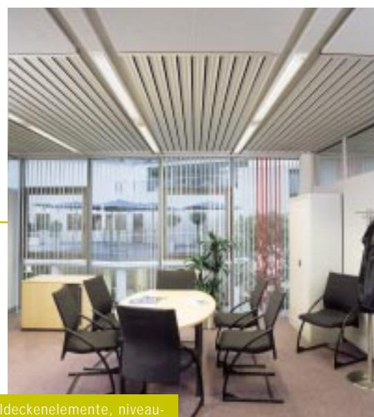
SKS-5 Kühldeckenelemente, niveaugleich mit einer Metall-Akustikdecke
