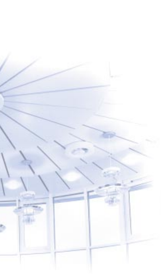
Gipskartondecke, gelochte Knauf-Thermoplatte mit Vlies und Scherf-Akustikputz, kombinierbar mit KKS-Kühlelementen
