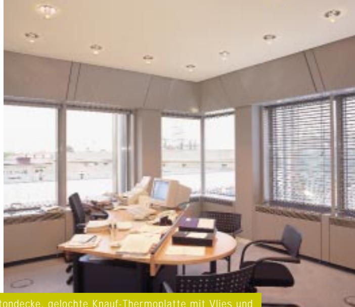
Gipskartondecke, gelochte Knauf-Thermoplatte mit Vlies und Scherf-Akustikputz, kombinierbar mit KKS-Kühlelementen
