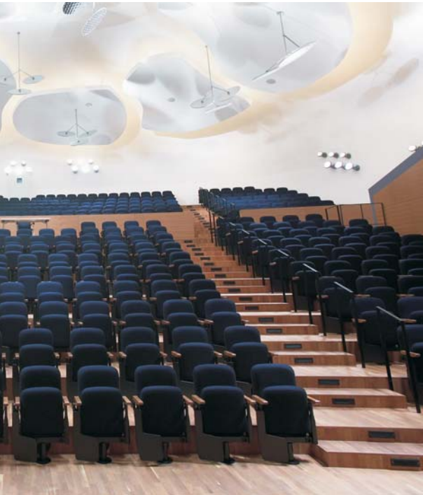
Step displacement outlets at Beiersdorf AG, Hamburg / D
