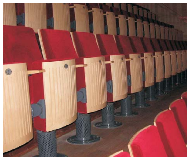
Seat displacement outlet, type Q-St, in the 'Muziekgebouw aan 't IJ', Amsterdam / NL
