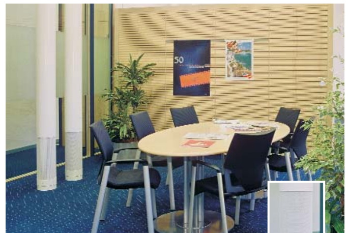
Circular displacement outlet, type Q-Z, at 'Norddeutsche Landeszentralbank' in Braunschweig / D
