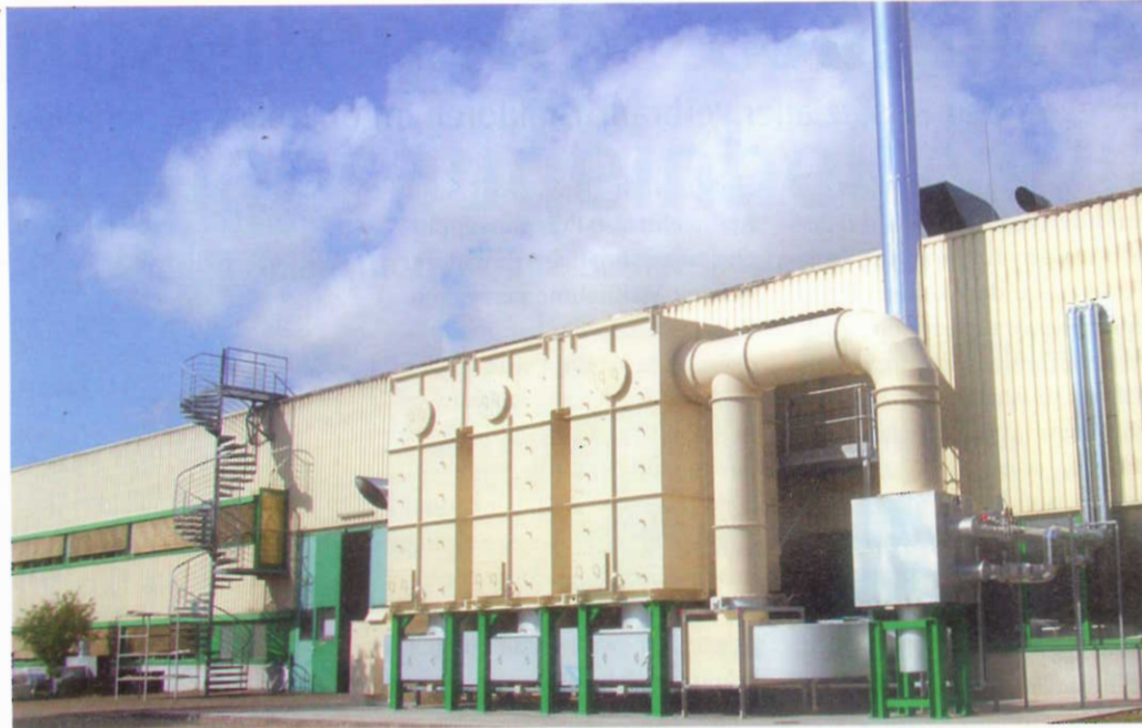
Mit einer regenerativen Nachverbrennungsanlage lässt sich Wärmeenergie im System halten und somit die Betriebskosten nachhaltig reduzieren.
