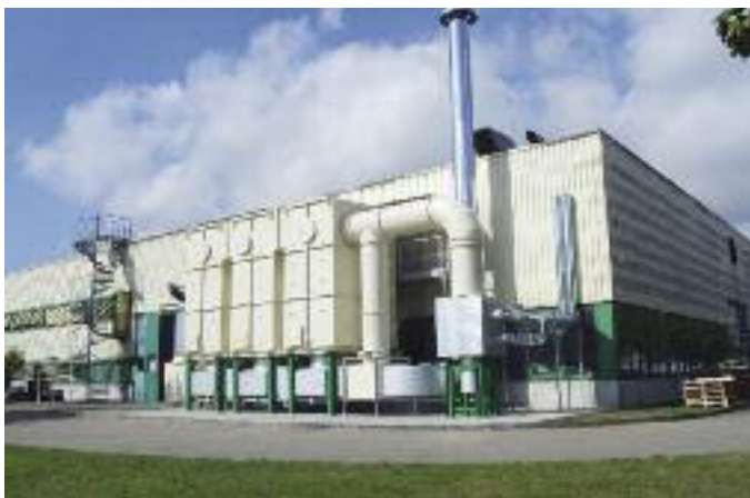
Abb. 1: Seitenansicht der neuen RNV, in das Erscheinungsbild der Produktionshalle eingebunden.
