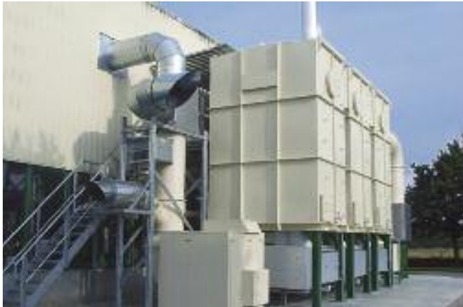
Abb. 2: Frontansicht der Anlage mit Treppenaufgang zur Bedienungsbühne.
