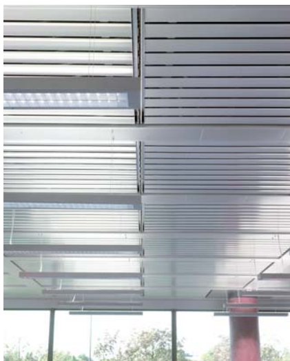
Abb.5 Deckenansicht mit der sichtbaren Luftdurchlassreihe (mittig im Bild)
