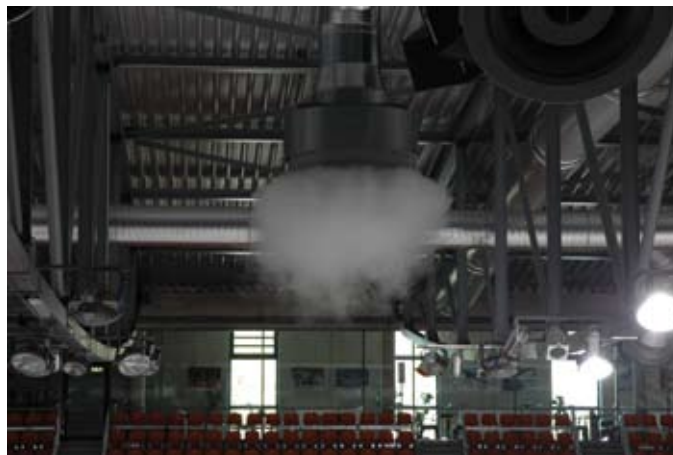
Bild 7: Zunächst quillt die Zuluft fast impulsfrei aus dem Auslass, ...
