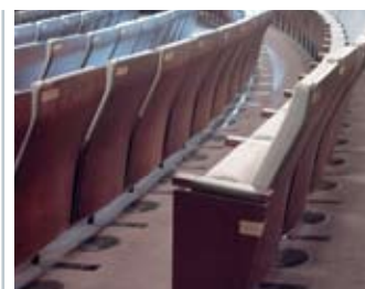
Bild 4 und 5: Das Theater am Goetheplatz in Bremen mit Bodendrallauslässen unter den Stühlen
